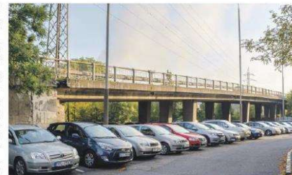
Nadjezd čeká kompletní rekonstrukce. Auto po něm budou jezdit až v září.
